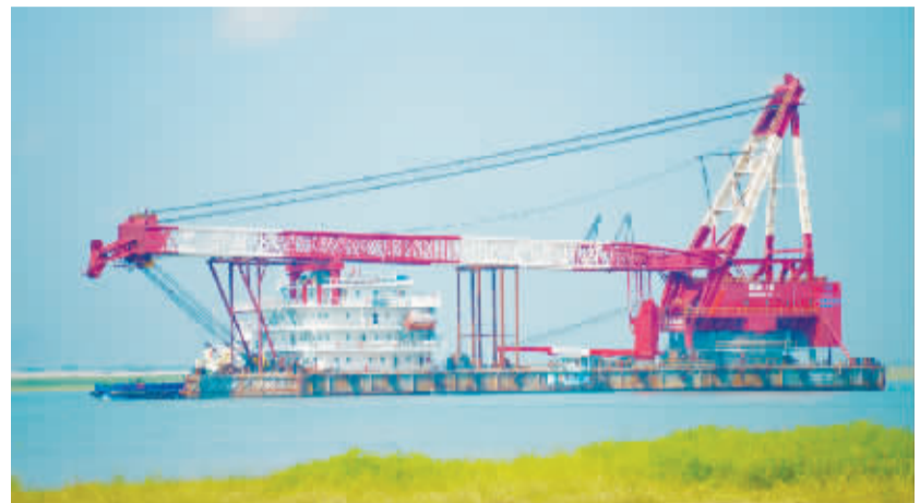
中铁大桥局千吨起重船抵达孟加拉国 这是5月20日在孟加拉国帕德玛大桥项目施工区域拍摄的中铁大桥局千吨起重船。经历一个多月的海上航行,从青岛起航的中铁大桥局“瑞航05”起重船于5月19日抵达孟加拉国帕德玛大桥施工区,为大桥建设提供重要保障。 新华社发
