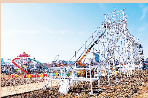
儿童公园项目即将竣工。
