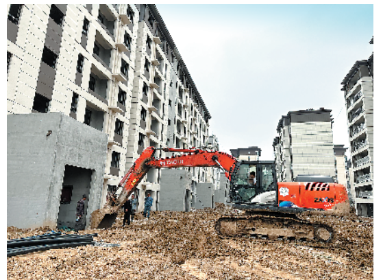
正商珑湖宽境一期工程正加紧施工。
