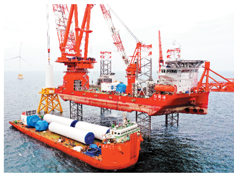
16兆瓦大容量海上风电机组在平潭外海开始安装
