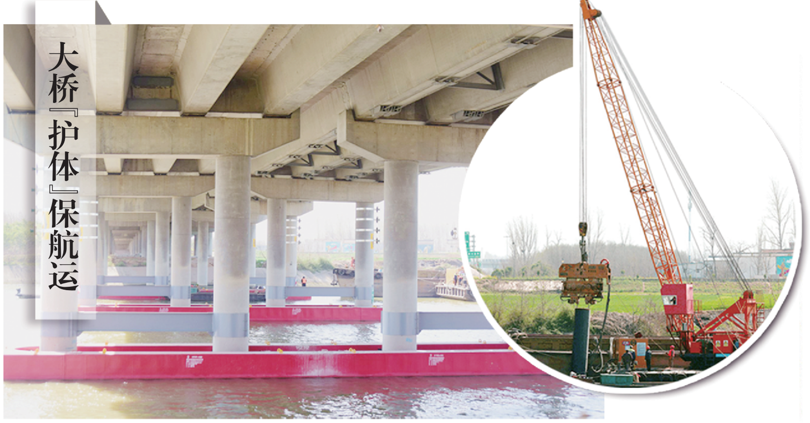
3月14日下午,施工人员在大桥高速跨沙颍河大桥下设置防撞钢柱,以保障航运和大桥安全。据了解,随着周口各港口开通越来越多的航运线路,沙颍河水上运输越来越繁忙,为保障航运安全,市港航管理局及有关部门加大沙颍河航道管护力度,对跨沙颍河大桥桥墩安装防撞设施,为周口发展临港经济、助力“豫货出海”提升护航能力。 记者 梁照曾 摄
