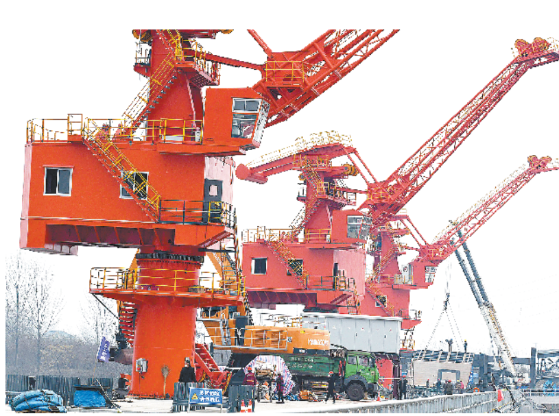
即将建成的沈丘港口物流园码头成为沙颍河生态经济带又一重要建设项目
