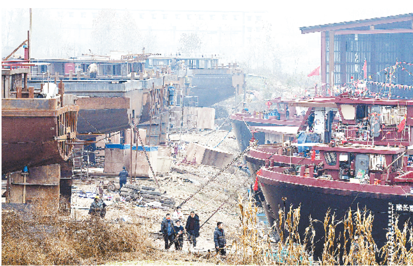
沈丘港口物流园区造船业紧密地生产中
