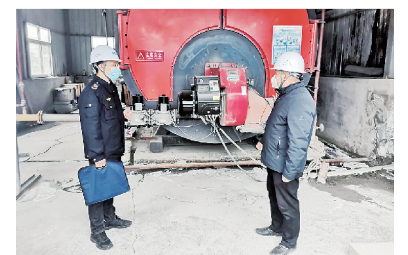
7条”“粉6条”重点整治事项,对每一个生产环节、关键部位、关键点,常态化开展日常安全生产检查,将各种安全生产隐患消灭在萌芽状态,为川汇区高质量发展营造安全稳定的环境。③12
