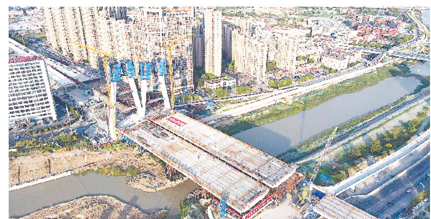
引江济淮金寨南路桥主桥贯通
